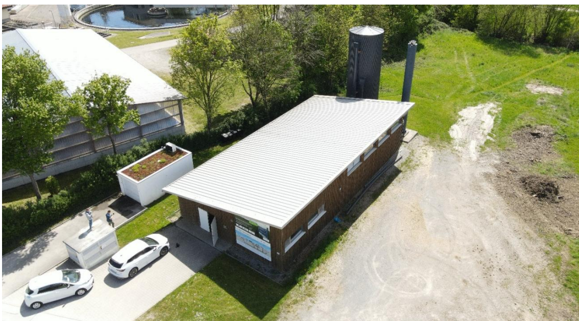
Abbildung 2: Luftaufnahme der Energiezentrale als Installationsfläche für eine Photovoltaikanlage (Quelle: IBS Ingenieurgesellschaft mbH)
